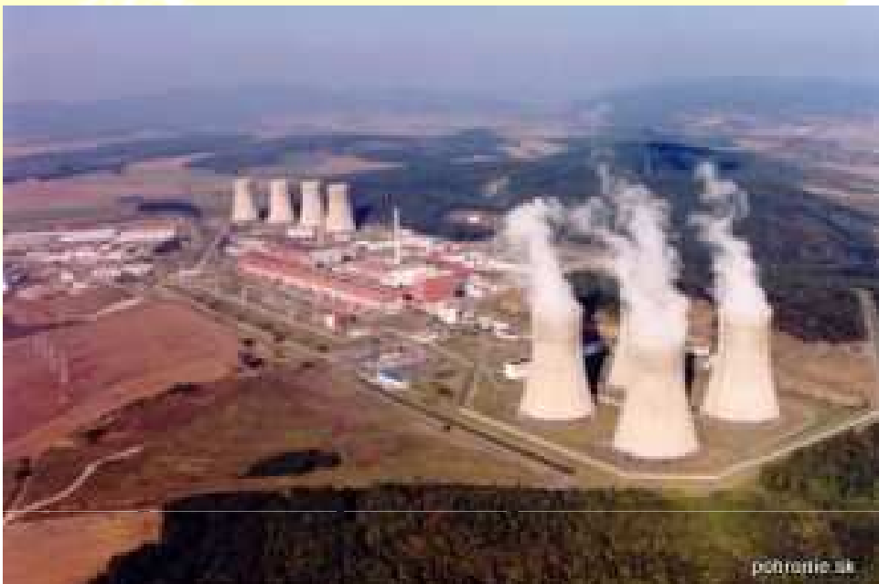
ómo nšta Jadrová elektráreň v Mochovciach
